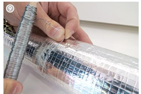
Die Rohrschale ist zusätzlich mit weichverzinktem Bindedraht zu sichern (min. 6 Umwicklungen pro Meter).
