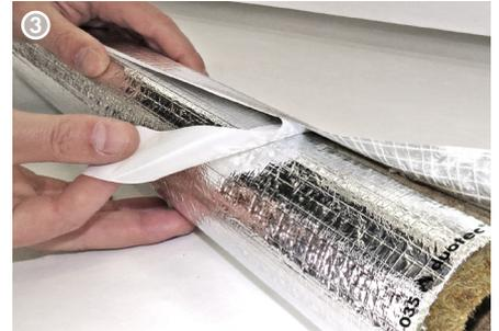
Schutzfolie der werkseitig aufgetragenen, selbstklebenden Überlappung abziehen und Längsschlitzung verkleben.
