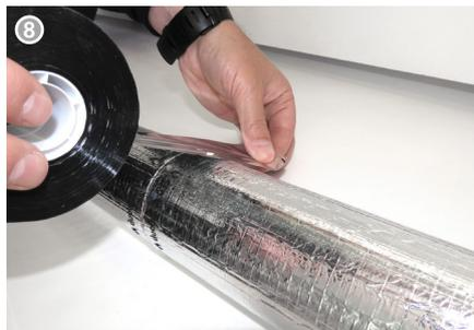
Querstöße der Schalen sind fugenfrei zu verlegen und zusätzlich mit geeignetem Klebeband des Herstellers zu sichern. Klebebänder generell mit Isolierspachtel glatt und fest andrücken.
