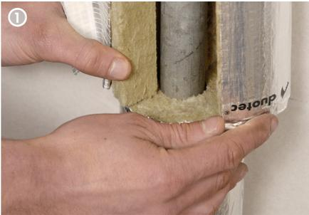
Die **duotec® Rohrschale** mit Aluminium-Kaschierung ist einseitig geschlitzt und lässt sich durch Aufklappen um das zu dämmende Rohr legen.
