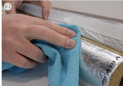
Vor dem Verschließen ist die **Rohrschale** passgenau zusammen zu drücken. **Es ist darauf zu achten, dass vor dem Schließen des Klebebandes alle Klebestellen staub-, fettfrei und trocken sind!**
